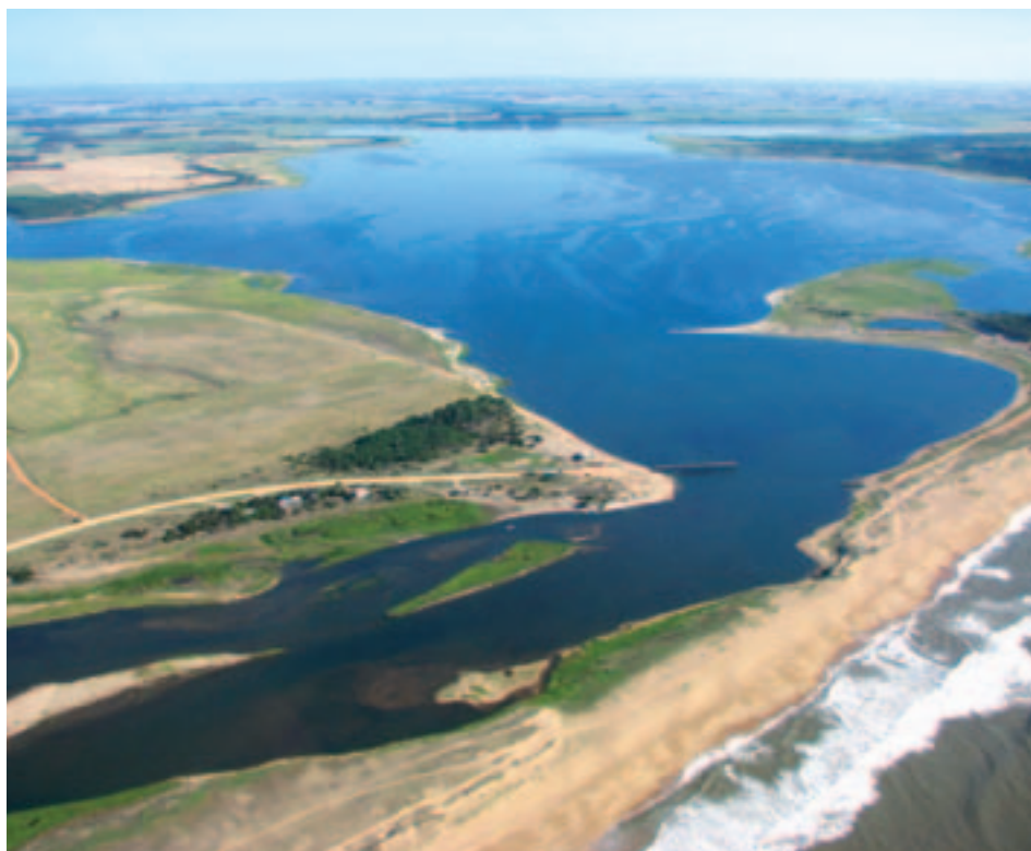
Puente inconcluso sobre Laguna Garzón, límite departamental de Maldonado con Rocha.
